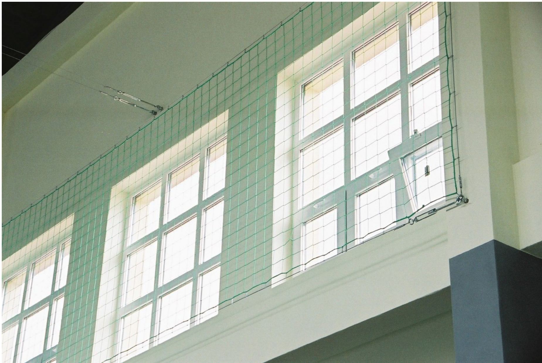
Siatka osłonowa bezwęzłowa, wykonana z polipropylenu. Grubość splotu 2,3mm 3,0mm, 4,0mm 4,75mm oczko 12x12 cm; 10x10cm; 4,5x4,5cm Kolory: zielony, biały, czarny, niebieski. Naciąg z lin stalowych. http://www.sport-transfer.com.pl/
